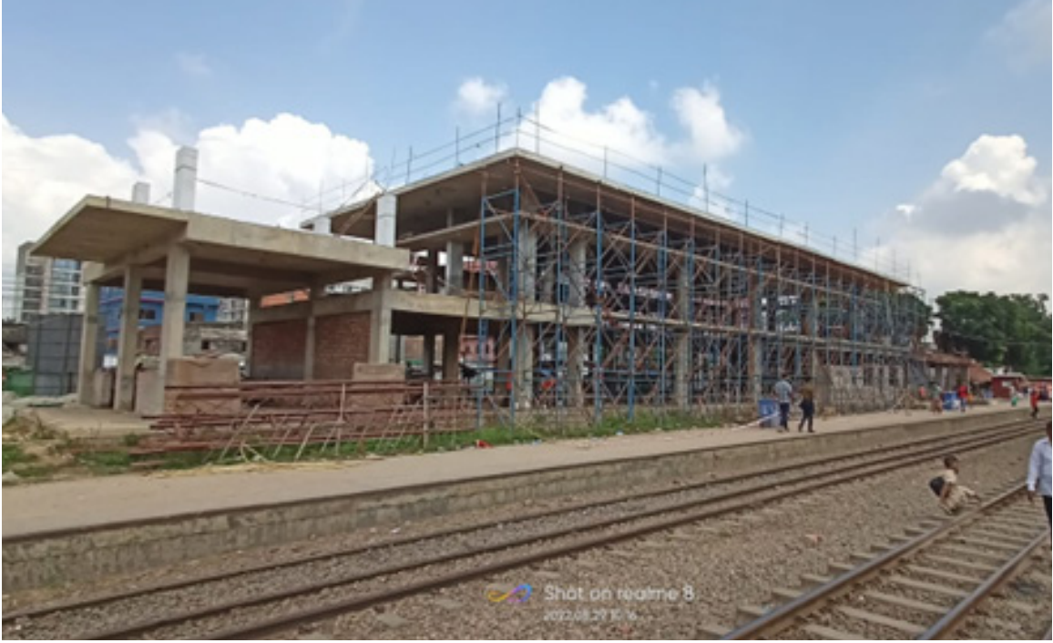
টঙ্গী রেলওয়ে স্টেশন ভবনের চলমান নির্মাণ কাজ
